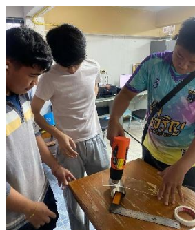
ภาพที่ 8 สร้างรูปคลี่ ตัด และม้วนท่อระบายน้ำทรงกระบอก โดยใช้เครื่องเป่าลมร้อน
