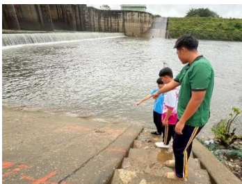
ภาพที่ 2 สำรวจการระบายน้ำจากประตูระบายน้ำคูริง
